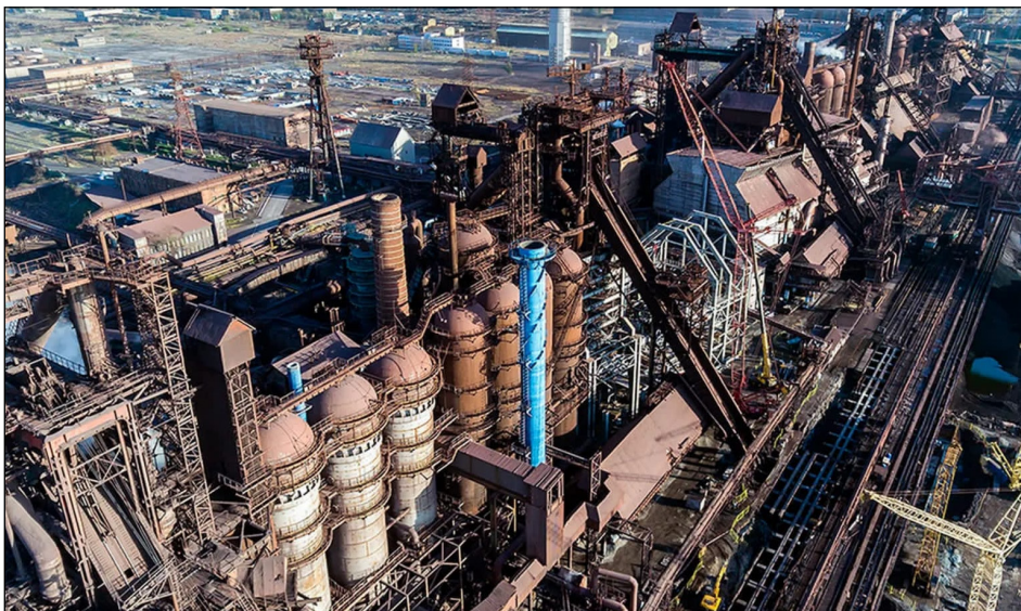
Planta siderúrgica de Arcelor Mittal
