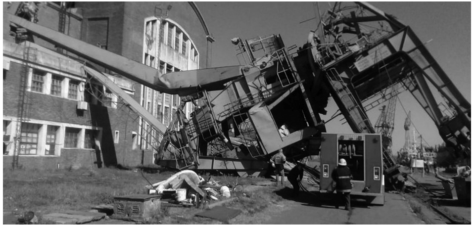
Derrumbe de una grúa en el ARS
